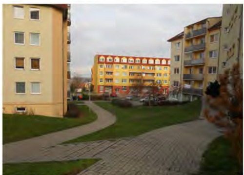
panelové sídliště na dolní Odoleně Vodě
