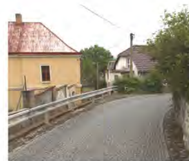
nevhodná svodidla v ulici Květnová pod kostelem
