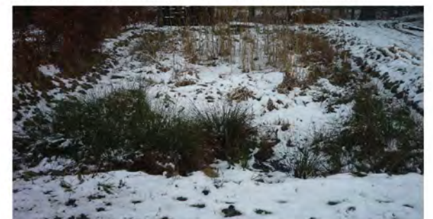
inspirace - kořenová čistička v zimě - voda čištěna bakteriemi
