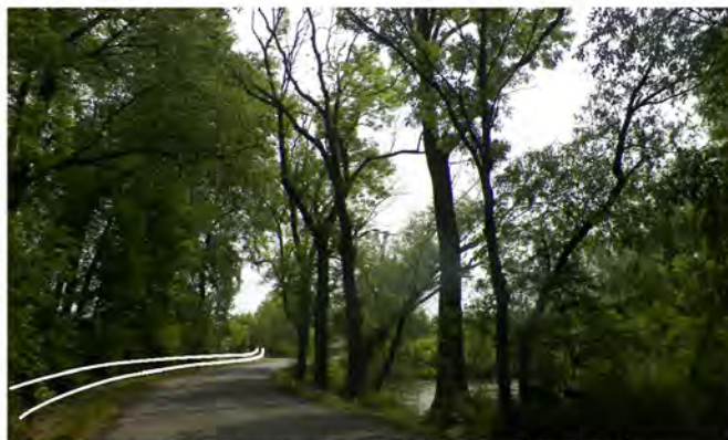
cyklostezka po staré železniční vlečce z Odoleny Vody do Úžic (pozemek ve vlastnictví města)
