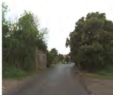
pohled na násup z vozovky
