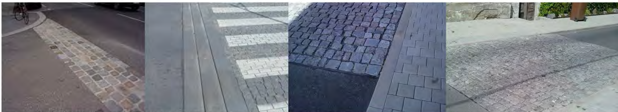
inspirace - prahy - zvýšení komunikace dlážděním v ploše přechodu či místa k přecházení
