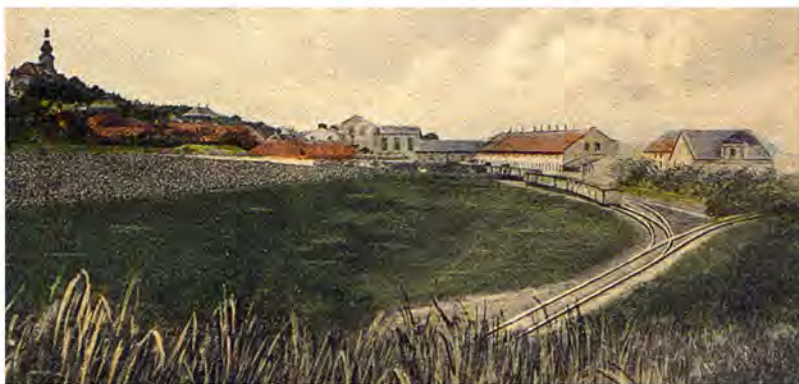
pohled na těleso vlečky - historická fotografie
